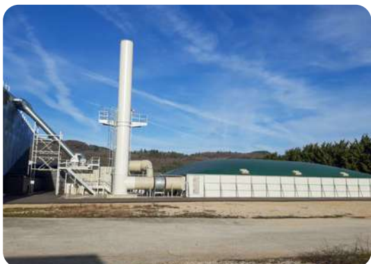
Le Biofiltre de Texen DECORATION en fonctionnement
