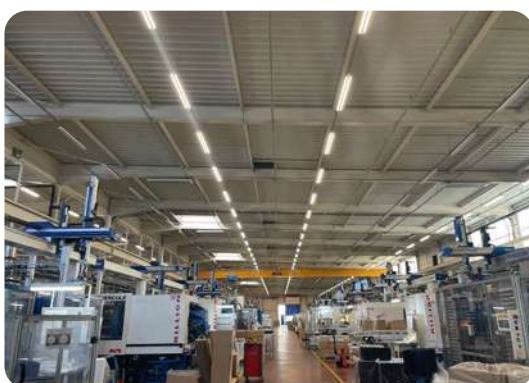
Optimisation de l'éclairage LED sur le site de Texen ROSE
