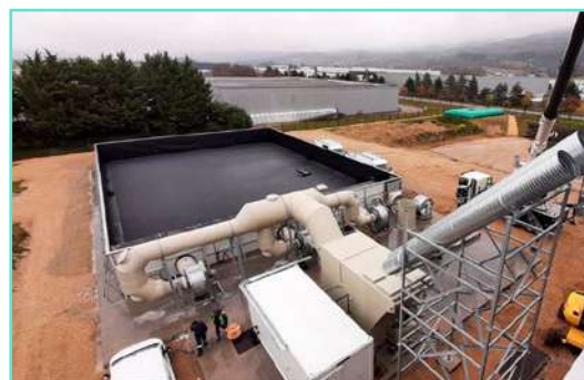
Installation en cours du biofiltre
