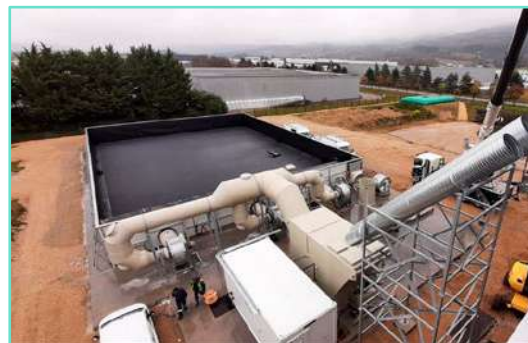
Installation en cours du biofiltre
